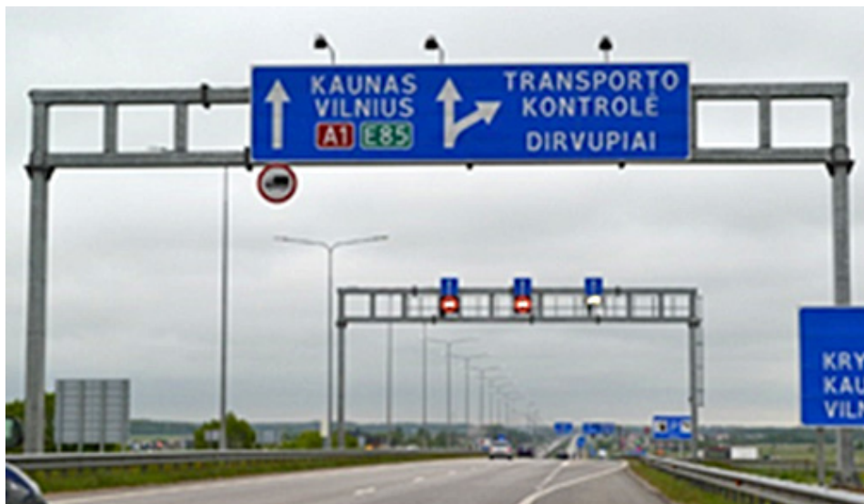
2 pav. Pirminė kelio ženklų atramos konstrukcija
