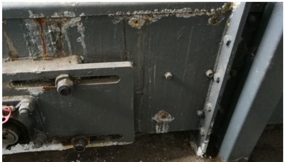
15 pav. Druskingos apnašos pelenų transporterio išorėje gali būti pakankamas indikatorius, kad katilė gali vykti korozija. Jeigu su vandens garais išeina į pelenų transporterį druskos, tai galima tikėtis didelio druskų poveikio ir katilo metalui
