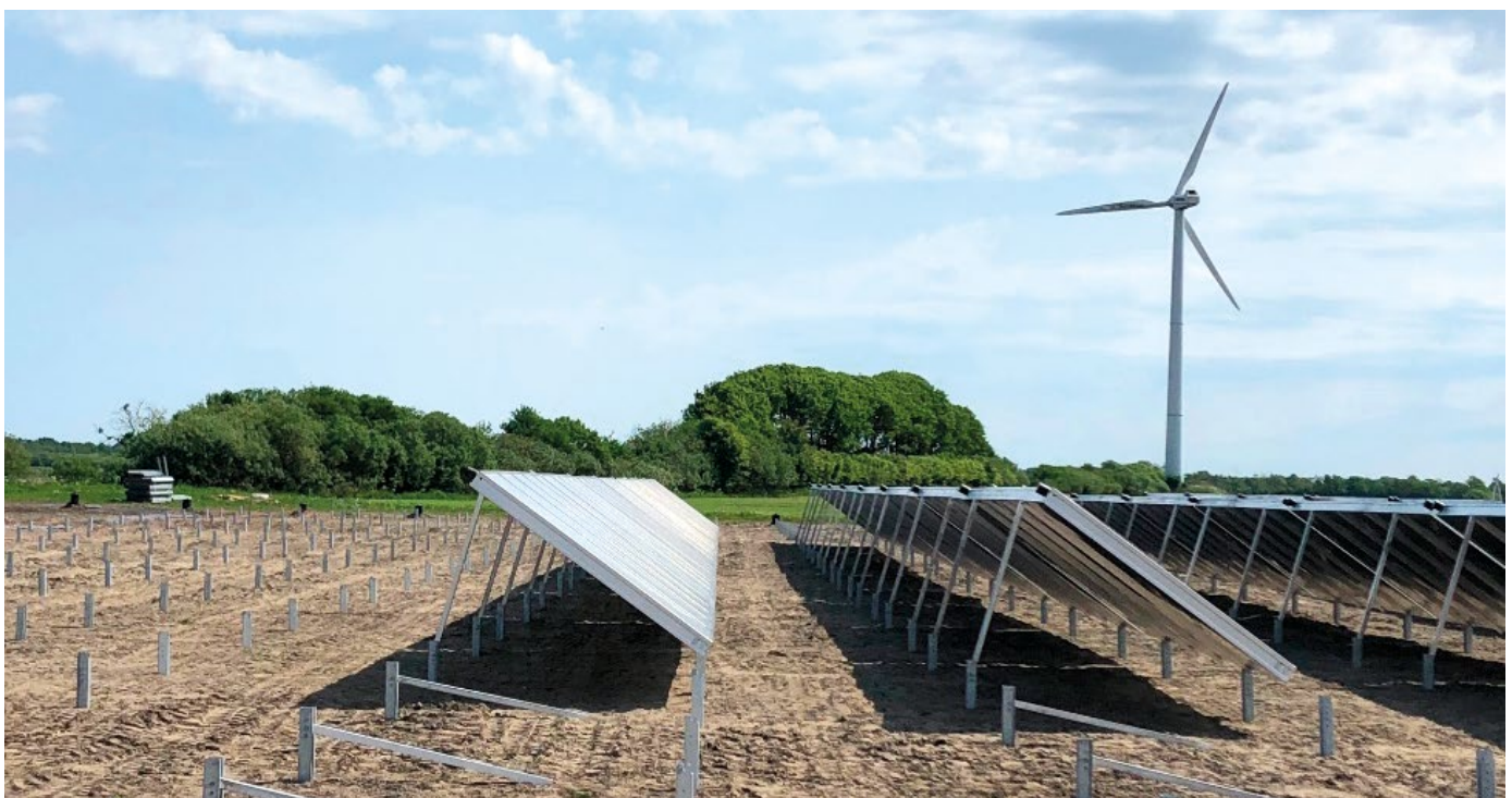
1 pav. Didelės galios saulės šiluminės jėgainės įrengimas integruojant vėjo turbiną ir biomasę
