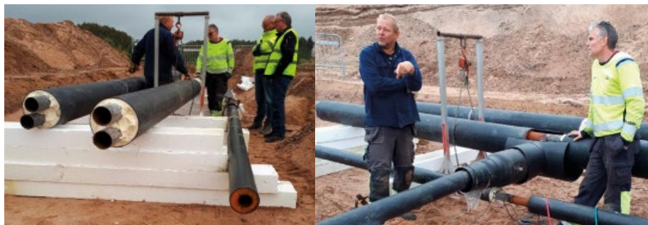
1 pav. Trivamzdės sistemos vamzdžių montavimas [Šaltinis: Halmstads Energi och Miljö AB]
