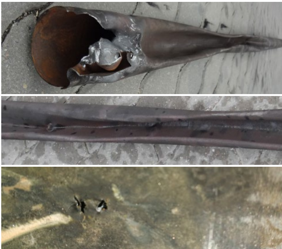
4 pav. Katilo vamzdžių pažeidimai dėl korozijos: viršuje – vamzdis sugniuždytas išorinio slėgio, viduryje – išilginis vamzdžio plyšimas dėl deformacijos, apačioje – kiaurinė korozija
