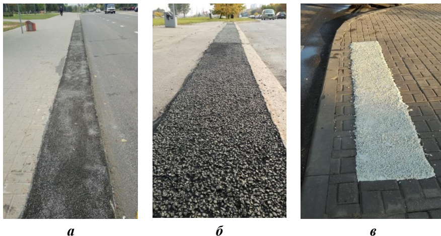
Рисунок 5.12. – Внешний вид полос противоскольжения: на остановочном пункте «Белавтогаз» (а), на остановочном пункте «Холмогорская» (б), полоса безопасности перед пешеходным переходом (в)
