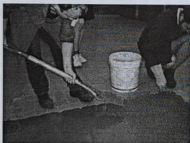
Укладка на полимерцементный слой минеральной смеси (отсев гранита фракции 2-4 мм +отсев дробления керамического кирпича фракции 0-5 мм обработанные разбавленной водной дисперсией эпоксидной смолы).
