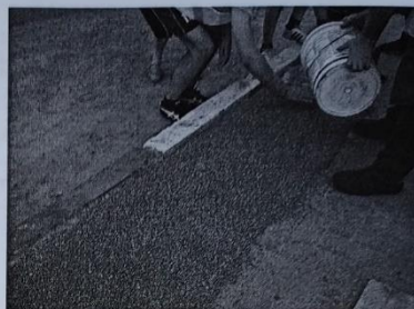
Нанесение отсева дробления гранита фракции 2-4 мм
