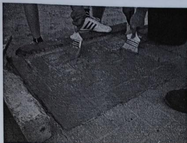
Нанесение полимерцементного состава на основе водной дисперсии эпоксидной смолы
