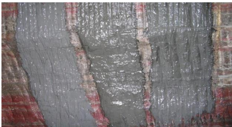
Рисунок 5.10. – Покрытия, нанесенные на солевую поверхность в вентиляционном штреке 2РУ ОАО «Беларуськалий», выполненное в ноябре 2011 г.
