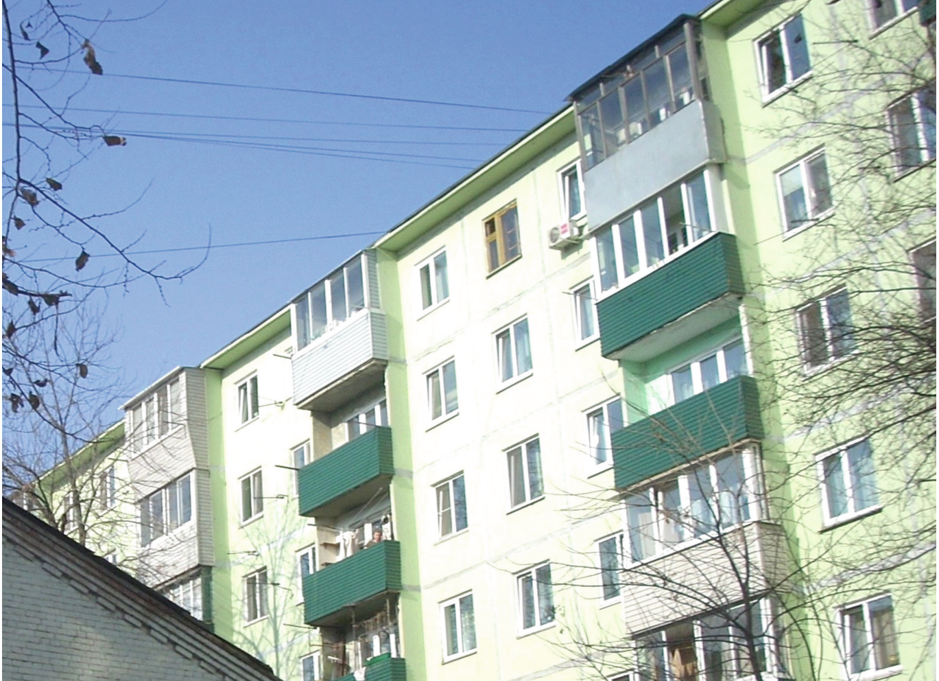
Abb. 14: Typisierter Wohnblock, 1966, Gorstrojprojekt, Arch. Philipp Tolziner, nach Sanierung, 2011. Foto: Astrid Volpert.
