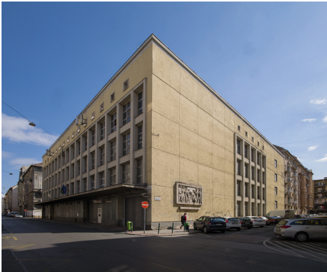
Abb. 11: Autogarage mit Werkstatt, Pannonia / Ecke Felka Straße. Foto: Rudolf Klein
