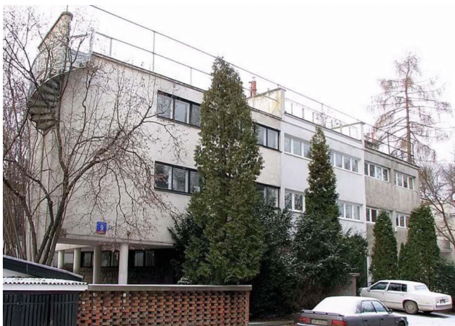
Abb. 1: Villa in Katowice (1928), Architekt: Bohdan Lachert. Foto: Romuald Loegler.
