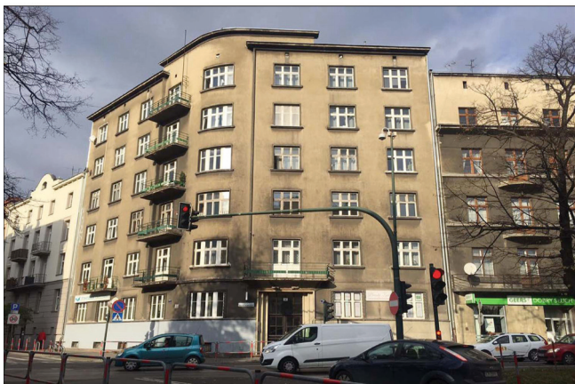
Abb. 7: Mietshaus in der Juliusz-Słowacki-Str. 58, Ecke Śląska Str. in Krakau, Architekten: Alfred Düntich und Stefan Landsberger. Foto: Romuald Loegler.
