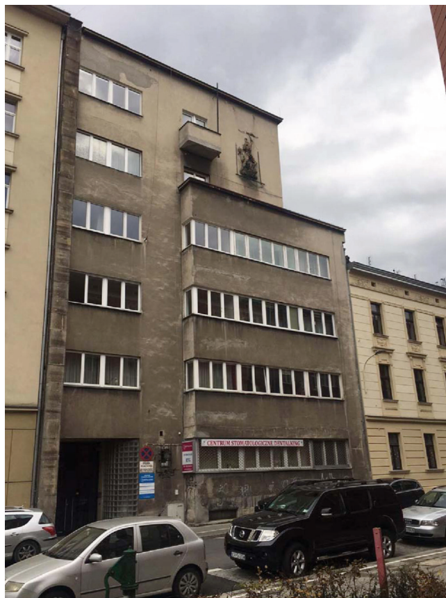
Abb. 8: Mietshaus in der Lenartowicza Str. 13 in Krakau, Architekt: Edward Kreidler. Foto: Romuald Loegler.
