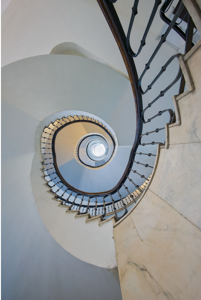
Abb. 9: Treppenhaus des Mehrfamilienhauses Pozsonyi Straße 40. Foto: Rudolf Klein.
