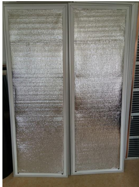
3.25 pav. Karkaso plokštės su papildoma termoizoliacine medžiaga
