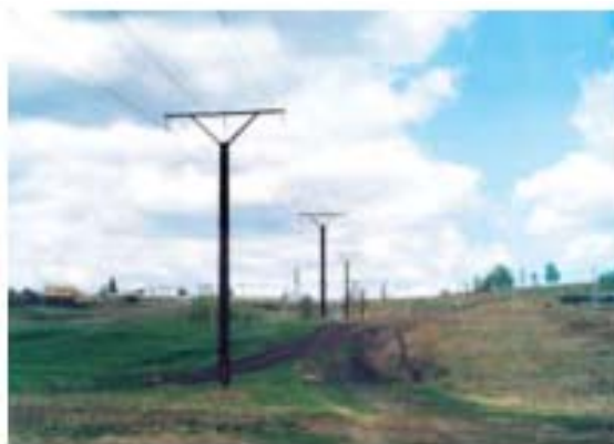
11 pav. Plieninė atrama su pakabinamais izoliatoriais
