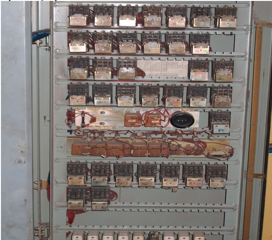
5.3.2.1.3 P2 pav. Valdymo pultas, komutavimo įrenginiai
