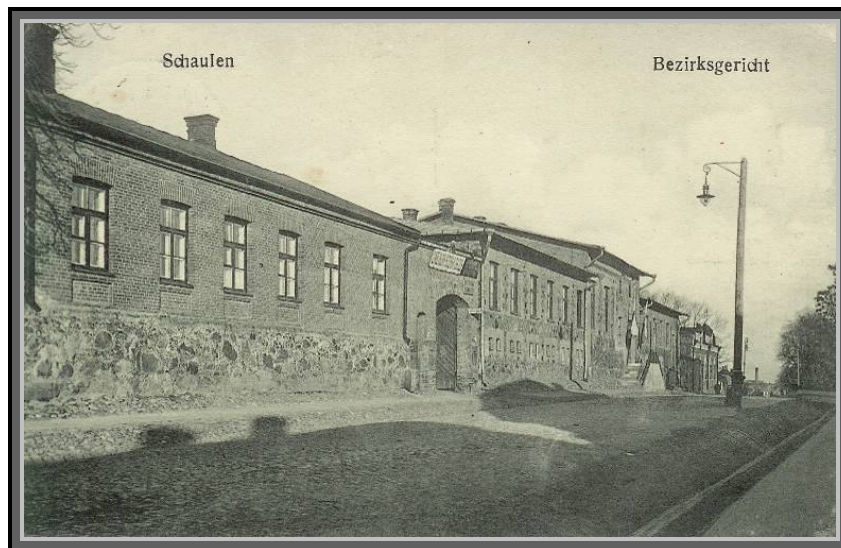
Atvirukas. 34.1.7. Apygardos teismas. Dab. Šiaulių apygardos teismo rūmai Dvaro g. Pastatas rekonstruotas. P.212
