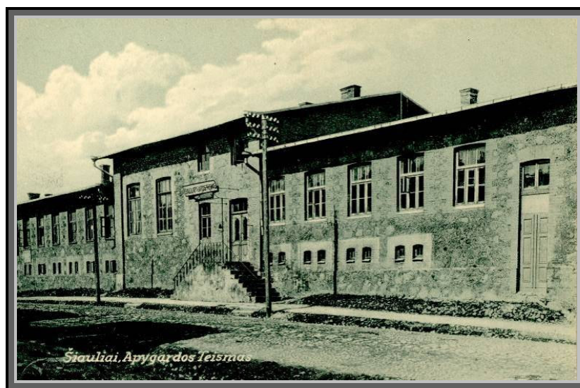
Atvirukas. 43.3.27. Šiauliai, Apygardos Teismas. Dab. Šiaulių apygardos teismo rūmai Dvaro g. Pastatas rekonstruotas. P.299
