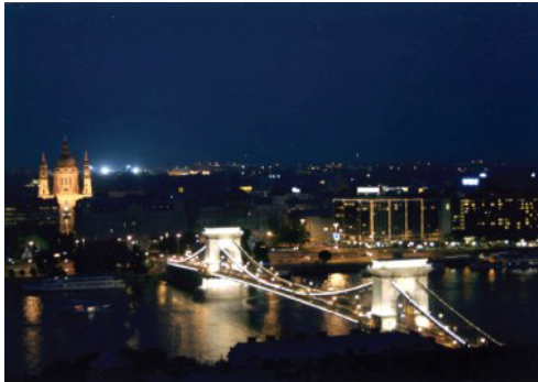
3 pav. Naktinis Budapeštas. Tiltas per Dunojų, jungiantis Budą ir Peštą. Lynai tarp dviejų pagrindinių atramų yra grandininės kreivės formos (autoriaus nuotrauka, 2004 m.).
