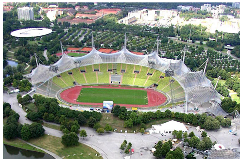
9 pav. Miuncheno olimpinis stadionas. Architektas O. Frei, 1972. Foto: Dave Morris iš Edinburgo, JK.
