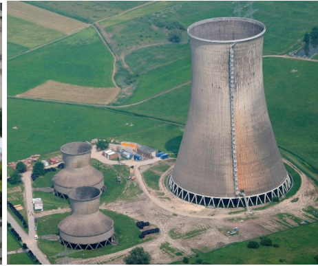
15 pav. Aušinimo bokštas Vestfalijoje, Vokietijoje. Dalies cilindrinio paviršiaus pakeitimas minimaliuoju didina bokšto atsparą vėjui.
