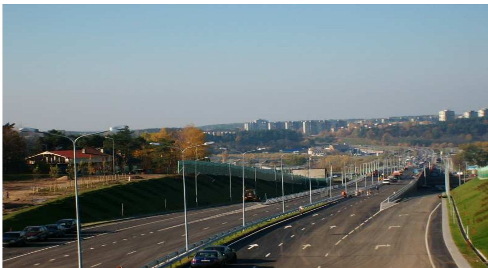
9 pav. Senamiesčio pietinis apvažiavimas nuo P. Višinskio g. iki Aušros Vartų g. Šaltinis: Projekto paraiška
