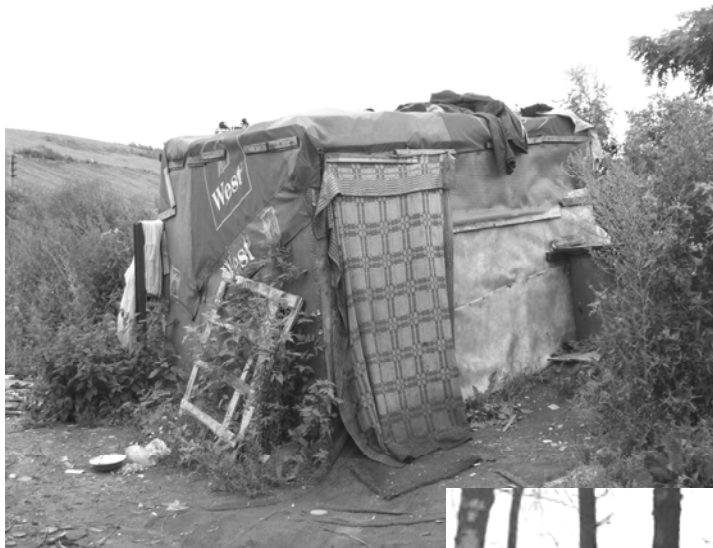
44 pav. Atliekų rinkėjo namelis: kubo formos medinis karkasas, apkaltas polietilenuis, kilimais, metalo plokštėmis. Be langų. Languotas užklotas atlieka durų funkciją (D.Petružytės nuotrauka, 2006 m.)
