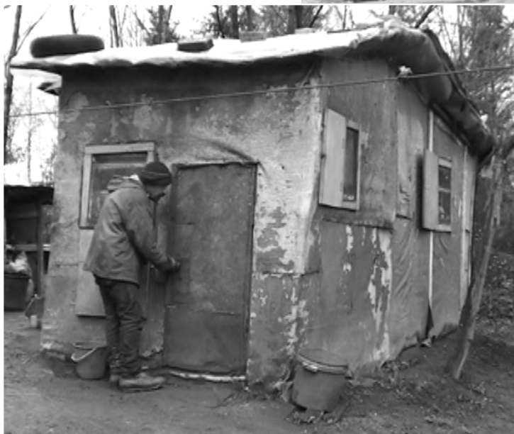
46 pav. Atliekų rinkėjo namelis dvigumomis sienomis, apšiltintas, su stikliniais langais ir rakinamomis durimis, grindimis ir viduje įrengtu pečiumi. (M.Survilos video įrašas, D.Petružytės iškarpa, 2008 m.)
