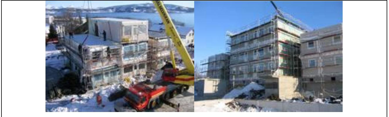
3 pav. Modulinio namo montavimas [46]
