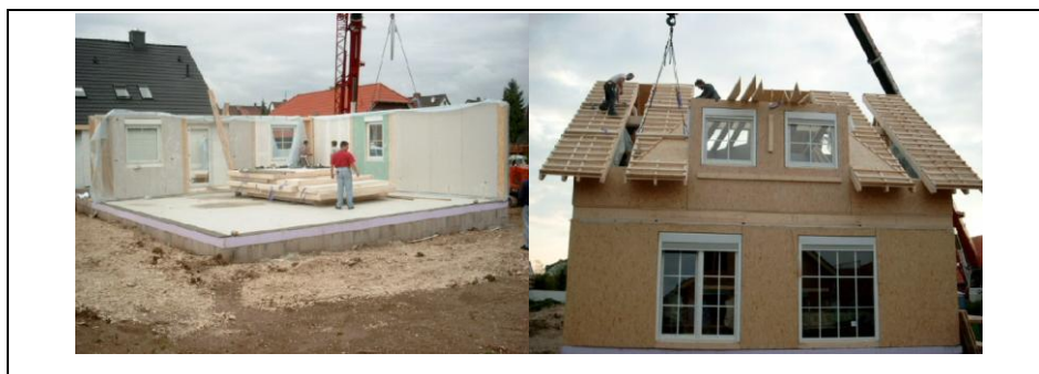
2 pav. Skydinio karkasinio namo montavimas [36]
