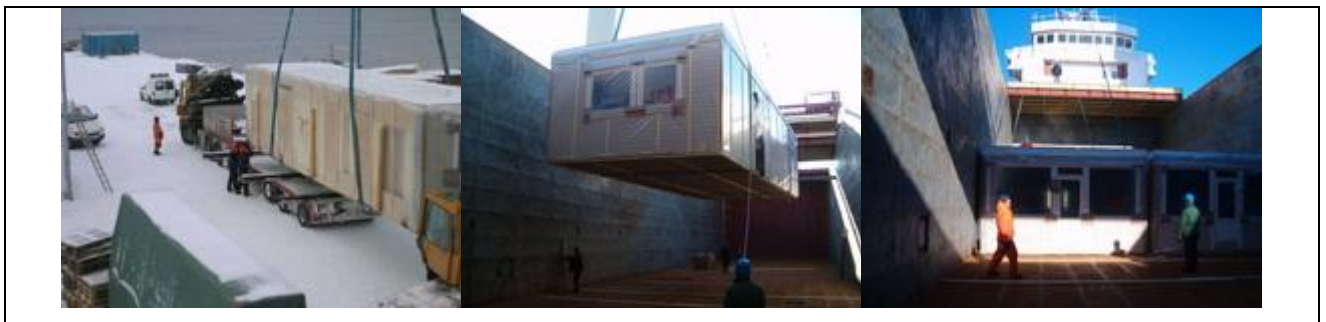
4 pav. Modulinio namo transportavimas [18]
