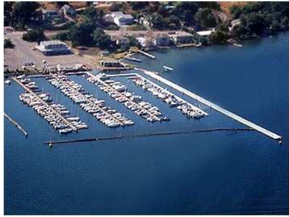
Betoninių platformų konstrukcijos - bangolaužiai ir švartavimo pirsai
