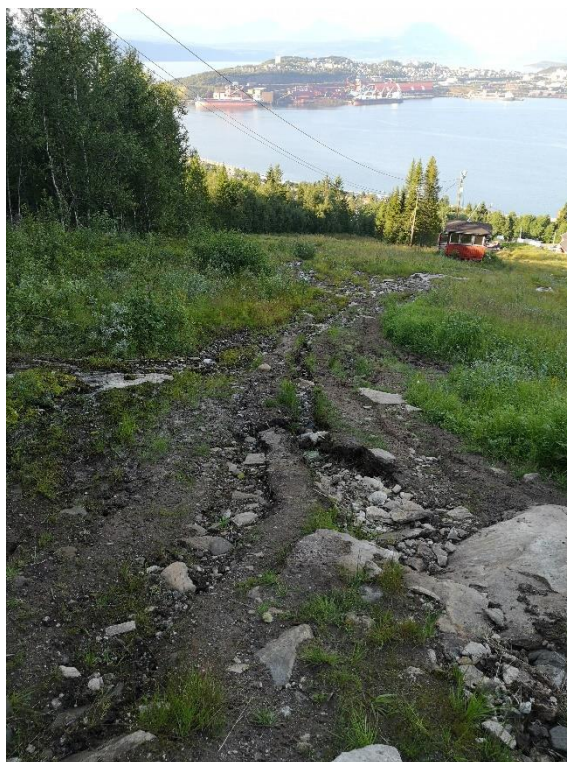
17 pav. Slidinėjimo trasos žemiausioje dalyje sunėštos sąnašos, vandens erozijos išgraužtas griovys
