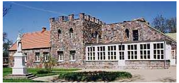
14 pav. Restauruoti Burbiškių dvaro rūmai
