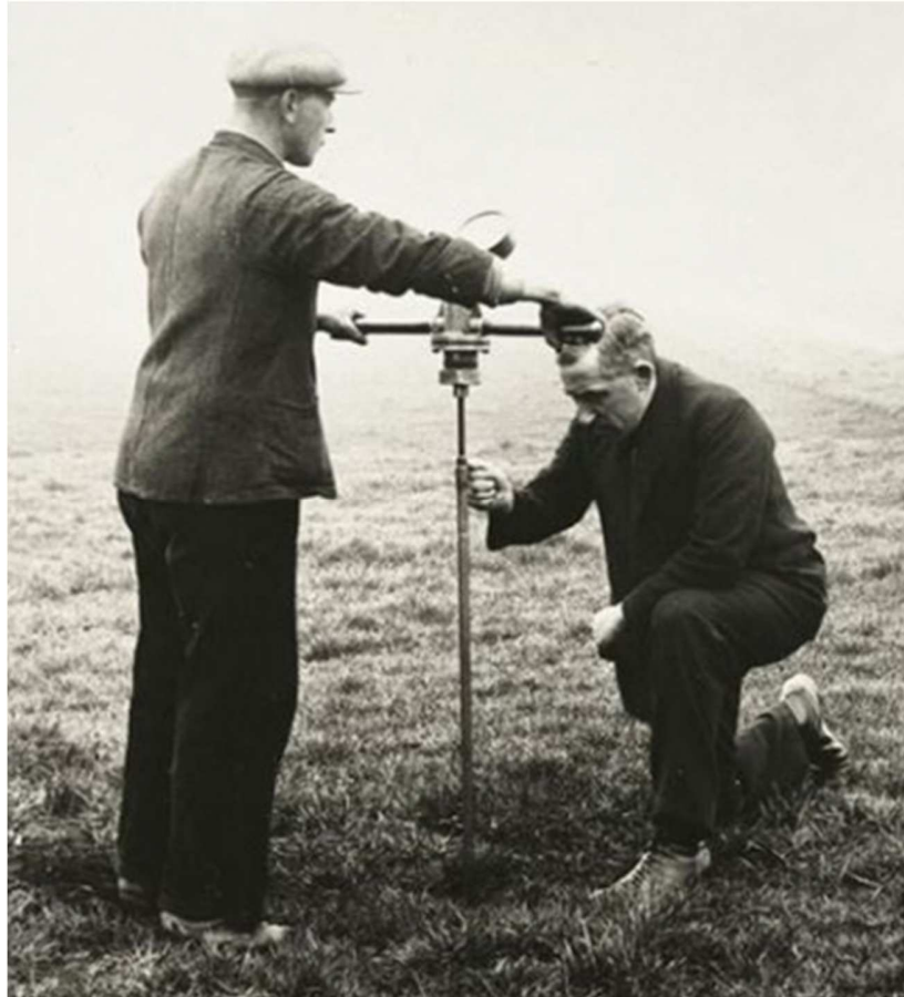
3.5 pav. Pirmieji statinio zondavimo bandymai štangomis – siekiant pereiti silpno grunto sluoksnį ir atsiremti į stiprų gruntą Nyderlanduose ( www.gouda-geo.com ).
