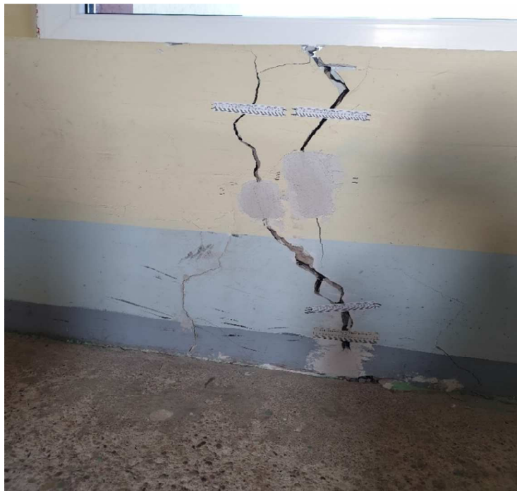
1.3 pav. Pastato deformacijos laiptinėje 2019 metai, 09 mėn. (autoriaus nuotr.)
