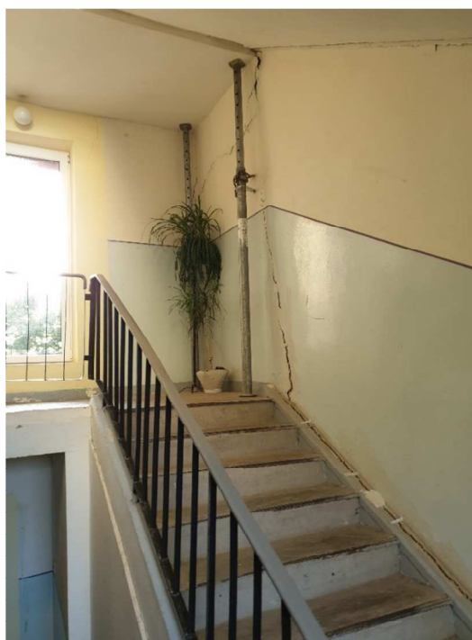
1.3 pav. Pastato deformacijos laiptinėje 2019 metai, 09 mėn. (autoriaus nuotr.)
