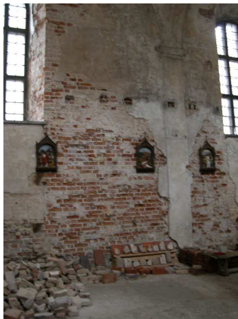
Nr. 8. Restauravimo darbai
