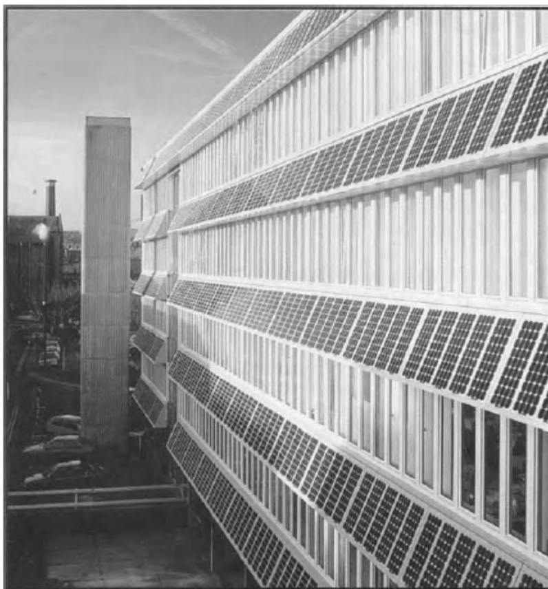
3.3 paveikslas. Integruotosios fotoelektrinės sistema įrengta ant Northumbria universiteto pastato sienos Jungtinėje Karalystėje, Newcastle [18].
