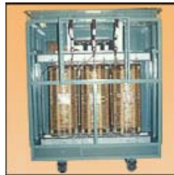
9.1. pav. ALT ir SGT 1000 kVA
