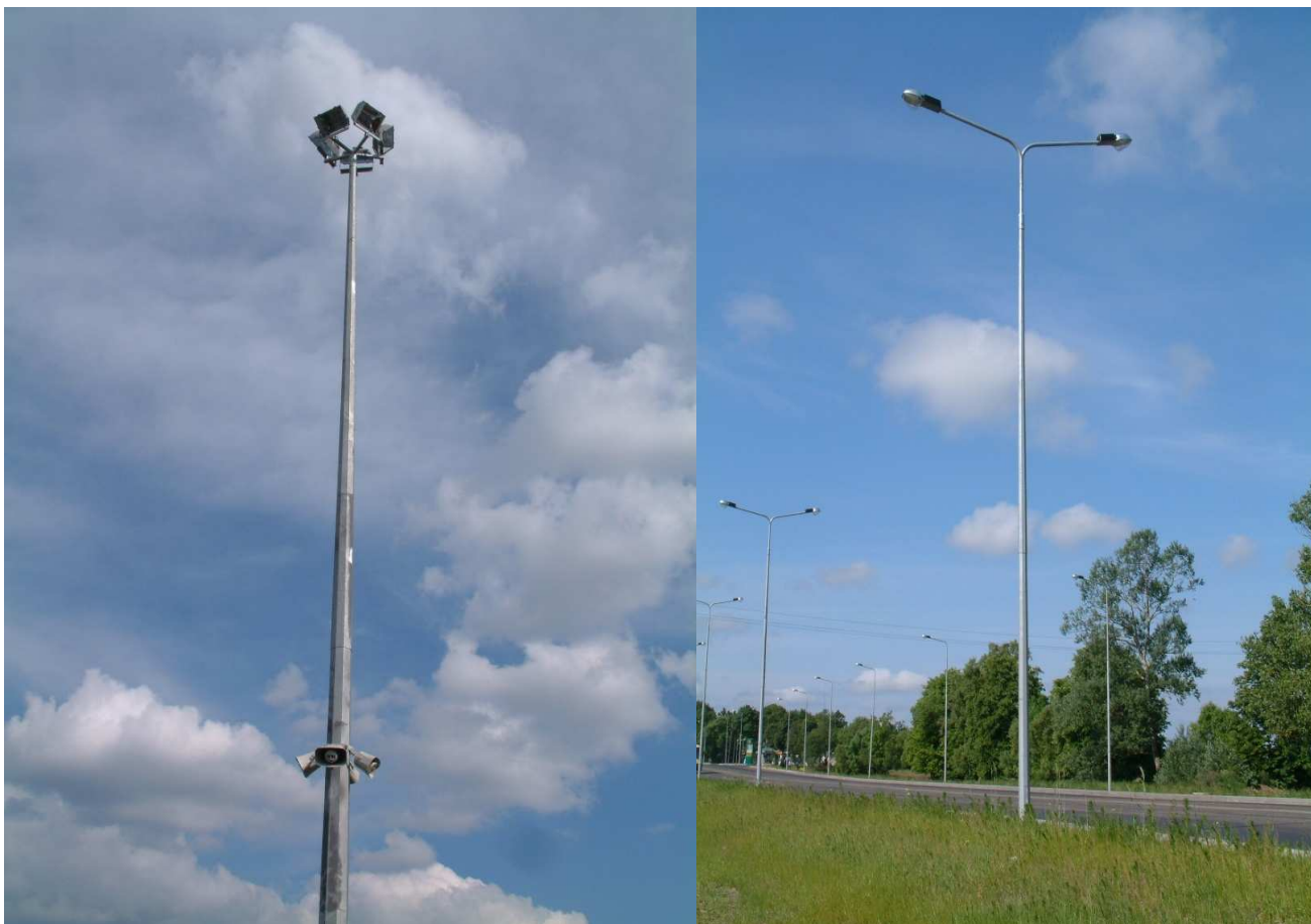
1.4 pav. 8 m aukščio gatvių apšvietimo atramos.
