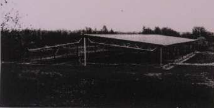
Dumblio saugojimo akvilių statė UAB „Jurbarkas“ statybininkai, dar suplykiantys į objektą sėdėti atbraudusių papildomų darbų.
