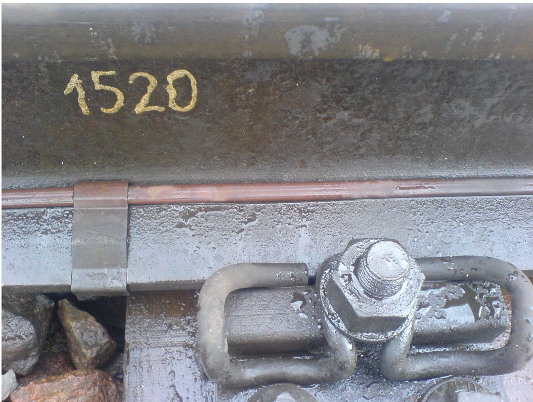
3.7 pav. apkaba išlinkusi.
