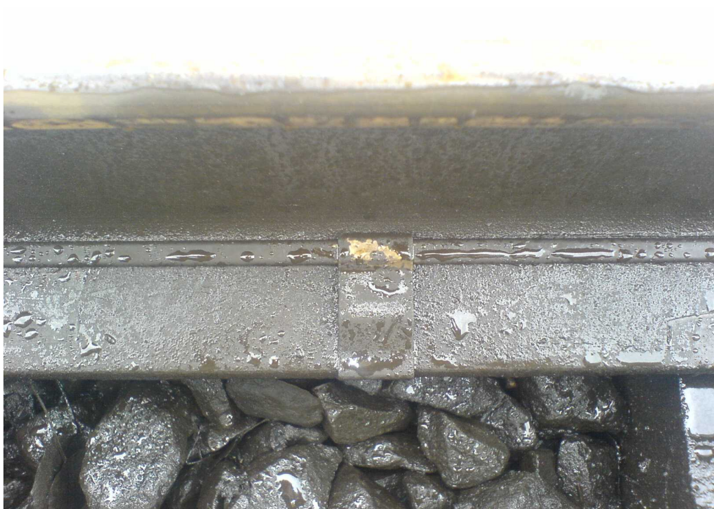
3.5 pav. tvarkingai pritvirtintas kaitinimo elementas.
