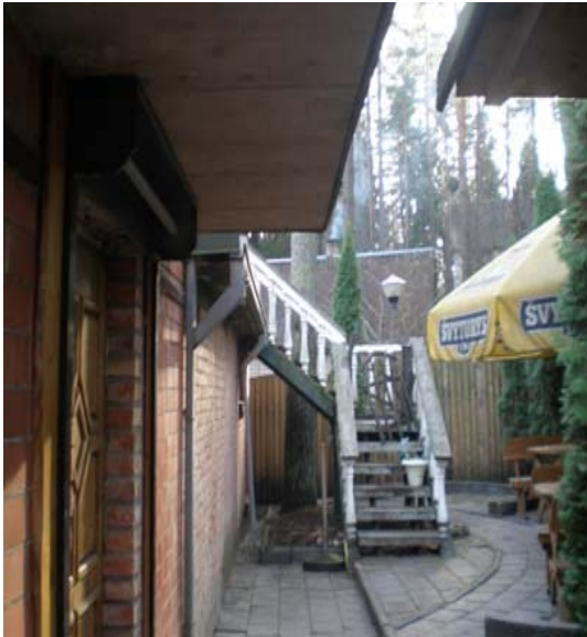
Iėjimas į antro aukšto patalpas.
