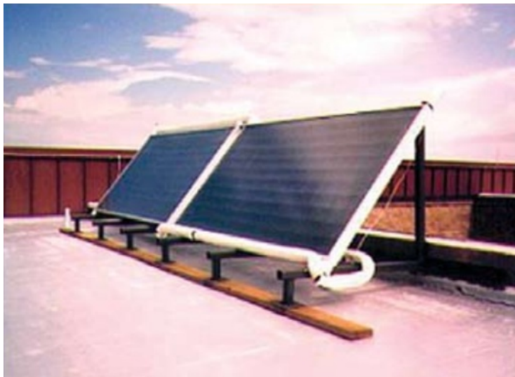
1.10 pav. Saulės kolektorių tvirtinimo konstrukcija
