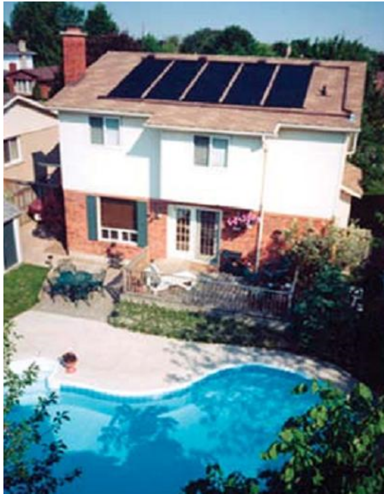
1.3 pav. Saulės kolektorinė baseino šildymo sistema
