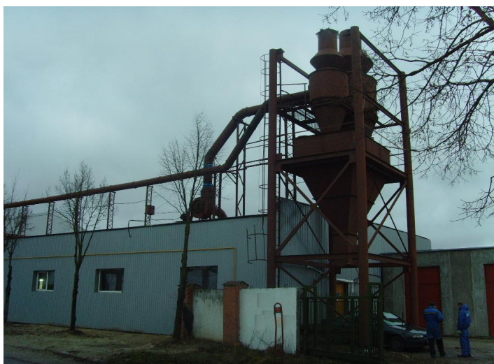
1.6 pav. Pjuvenų surinkimo agregatas (ventiliatorius);
