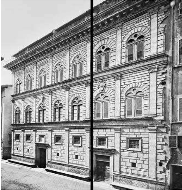
5. Palazzo Rucellai pagrindinis fasadas. Juoda linija skiria prirminį (iš kairės) ir vėlesnį rūmų variantus. ( http://cache-media.britannica.com.cdnetworks.net/eb-media/44/42244-004-53A6B687.jpg [žiūrėta 2009 04 19]).
