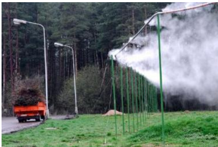
4 pav. Vilniaus nuotekų valyklos kvapų užkarda (Kvapų valdymo metodinės rekomendacijos, 2012)
