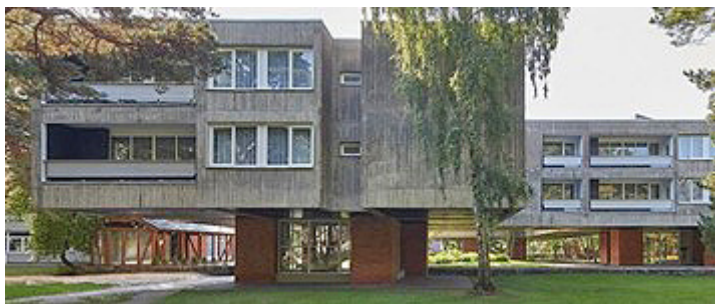
3 iliustracija. LSSR Ministrų Tarybos poilsio komplekso „Žilvinas“ poilsinė (archit. Algimantas Lėckas, MSPI, 1967–1969 m.). Rekreacijai pritaikyta architektūra. Iš: Pastatai kalba „Žilvinas“ hotel, nuotrauka N. Tukaj, [interaktyvus]: https://pastataikalba.lt/palanga/en/building/zilvinas-hotel-palanga/ , [2024-05-23].
