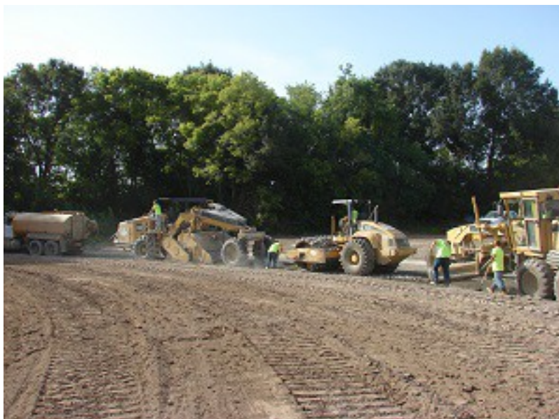
1 pav. Kelio pagrindo modifikavimas grunto-cemento mišiniu (www.glennlegeconstruction.com).
