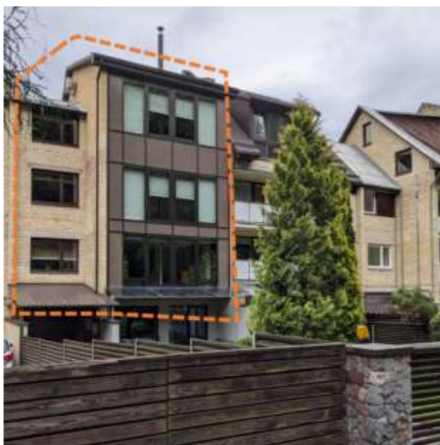
19 pav. Kairėje: vieno iš butų vakariniame korpuse radikali rekonstrukcija, atlikta 2009 m. Panaikinti balkonai, panaikintas šlaitinis stogas, pakeista fasado danga; kairėje matosi padidintas laiptinės į mansardą tūris ir aukštingumas. 2021 m. nuotr.
