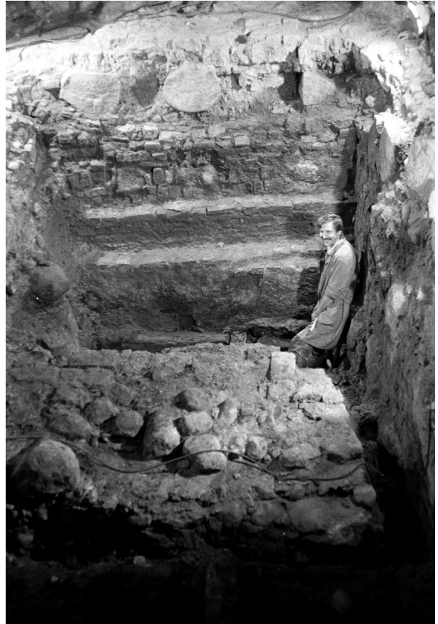
2 pav. Vilniaus Žemutinės pilies mūrai 1990 metais Fig. 2. Masonry of the Vilnius Lower Castle, 1990.
