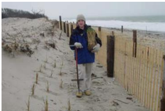
2 pav. Kopų stabilizavimo darbai įrengiant apsauginę tvorelę ir ją apsodinant augalais Duksburio paplūdimyje. (O'Connell, 2008)
