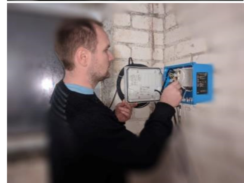
3.3-2 paveikslas. Optinio oksimetro COS61D tvirtinimas, maitinimo ir tinklo sujungimas su CM442
