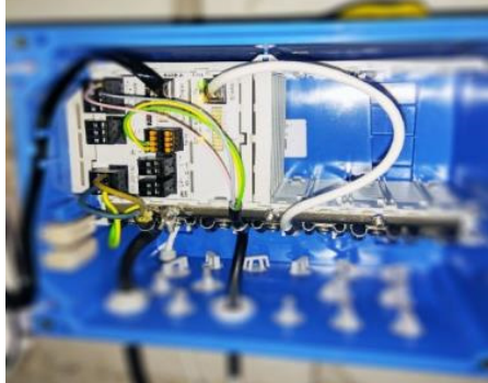
3.3-2 paveikslas. Optinio oksimetro COS61D tvirtinimas, maitinimo ir tinklo sujungimas su CM442
