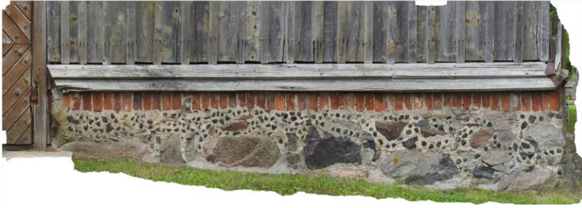
6 pav. ~27 Megapikselių ortofotografija – tai tikslios geometrijos, aukštos rezoliucijos fotografacija, tinkanti matavimams atlikti. Paimta iš VŠĮ „Paveldo komunikacija“, UAB „Terra Modus“ archyvų.
