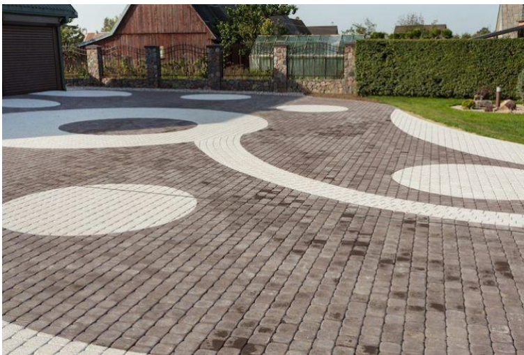
Pav. Nr. 75 ( Betono trinkelėjų išklotas kiemas)
