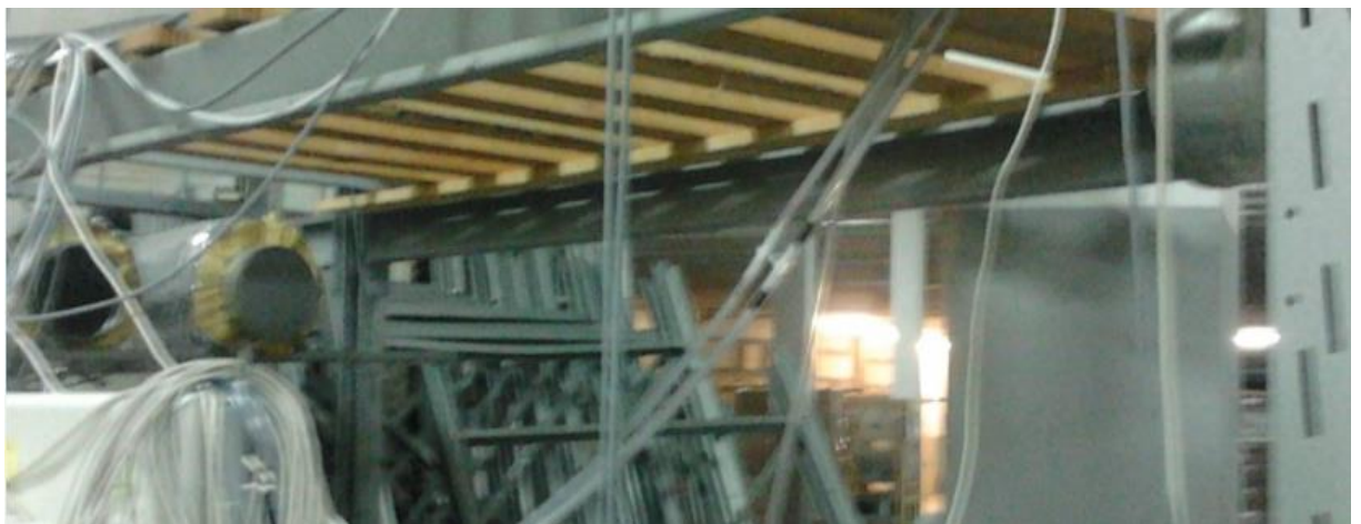
2.12 pav. Vėdinimo agregato pajungimo sektorius (matomi izoliuoti pajungimo ortakiai)
