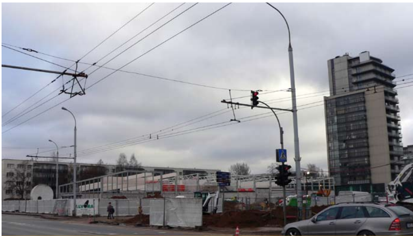
4. Nowy supermarket w budowie na terenie byłego centrum handlowego Žirmūnai. Wieżowiec po prawej stronie został ukończony w 2006 roku, zanim zniesiono ochronę prawną osiedla (fot. autor, 2017)
